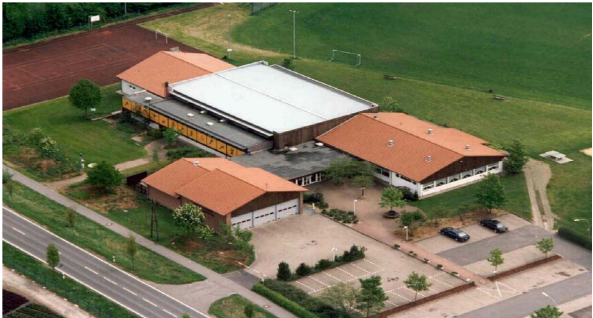
Gemeindezentrum mit Mehrzweckhalle, Feuerwehrgerätehaus und Restaurant "Bürgerhaus"
